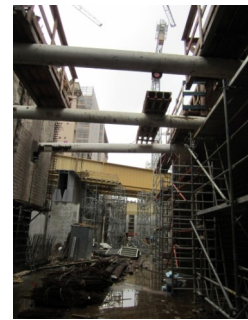
De grote werkzaamheden in en rond de Staatsoper.
